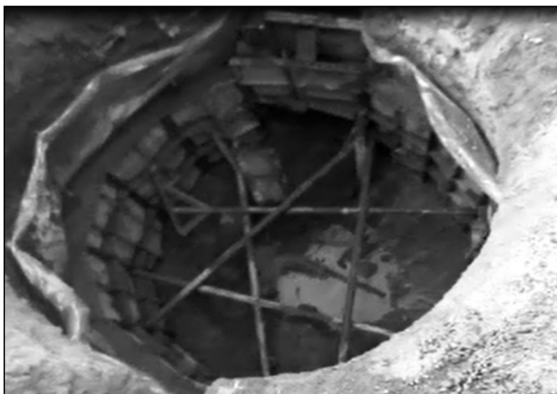
شکل ۷- مراحل ابتدایی بتن ریزی هاضم
