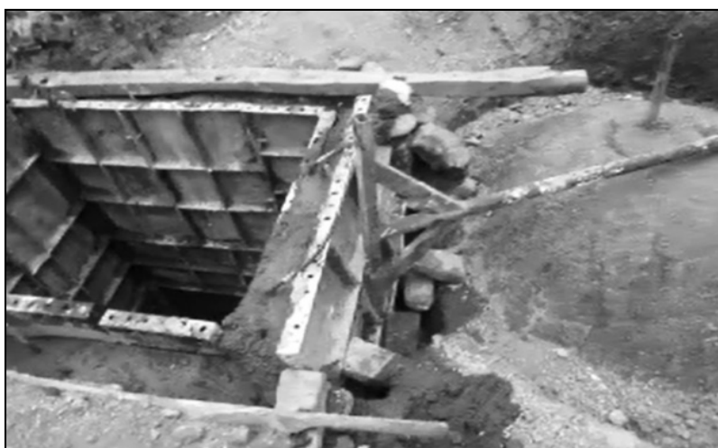
شکل ۸- مراحل آخر بتن ریزی هاضم
