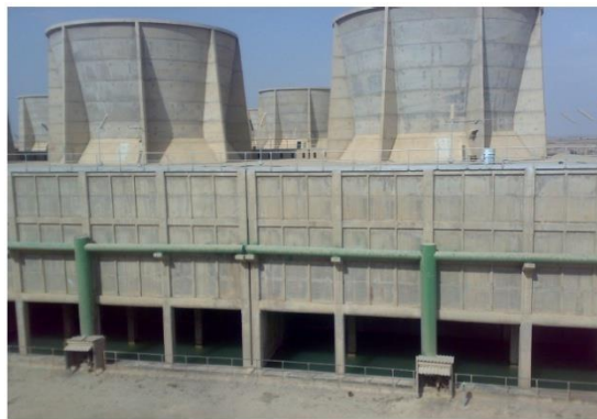
شکل ۱- برج‌های خنک کن نیروگاه رامین اهواز
