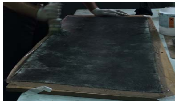
شکل ۶- ساخت نمونه‌ها به روش لایه چینی دستی
